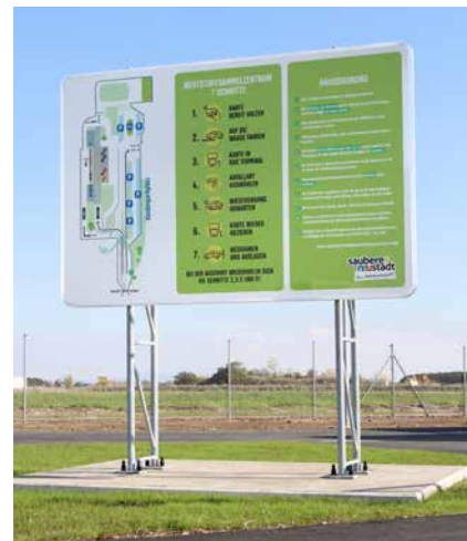
Die großflächigen Schilder wurden auf Kragmasten und T-Ausleger montiert.
