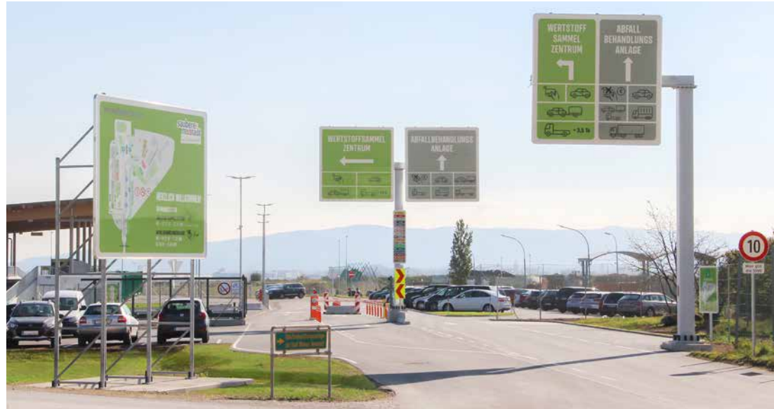
Die großflächigen Schilder wurden auf Kragmasten und T-Ausleger montiert.
